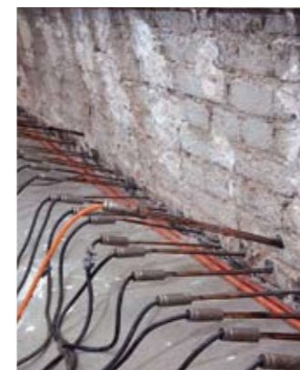
Trocknung eines Wandabschnitts mit Heizstäben.
