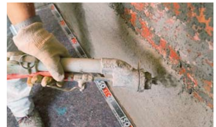
Der Sanierputz wird mit der Maschine aufgebracht.
