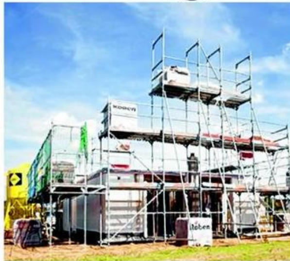
Baustart Im Juli 2010 geht es los: Die Bodenplatte ist gegossen und das Erdgeschoss inklusive Decke ist fertig.
