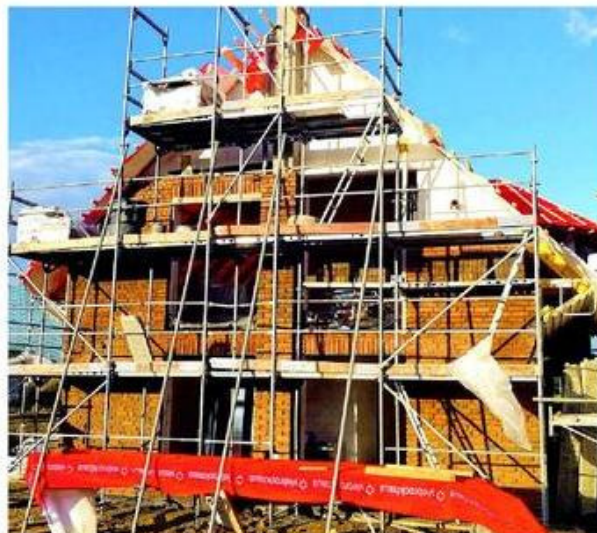
Rohbau Jetzt ist bereits die Gartenseite des Hauses fast komplett verklintert.
