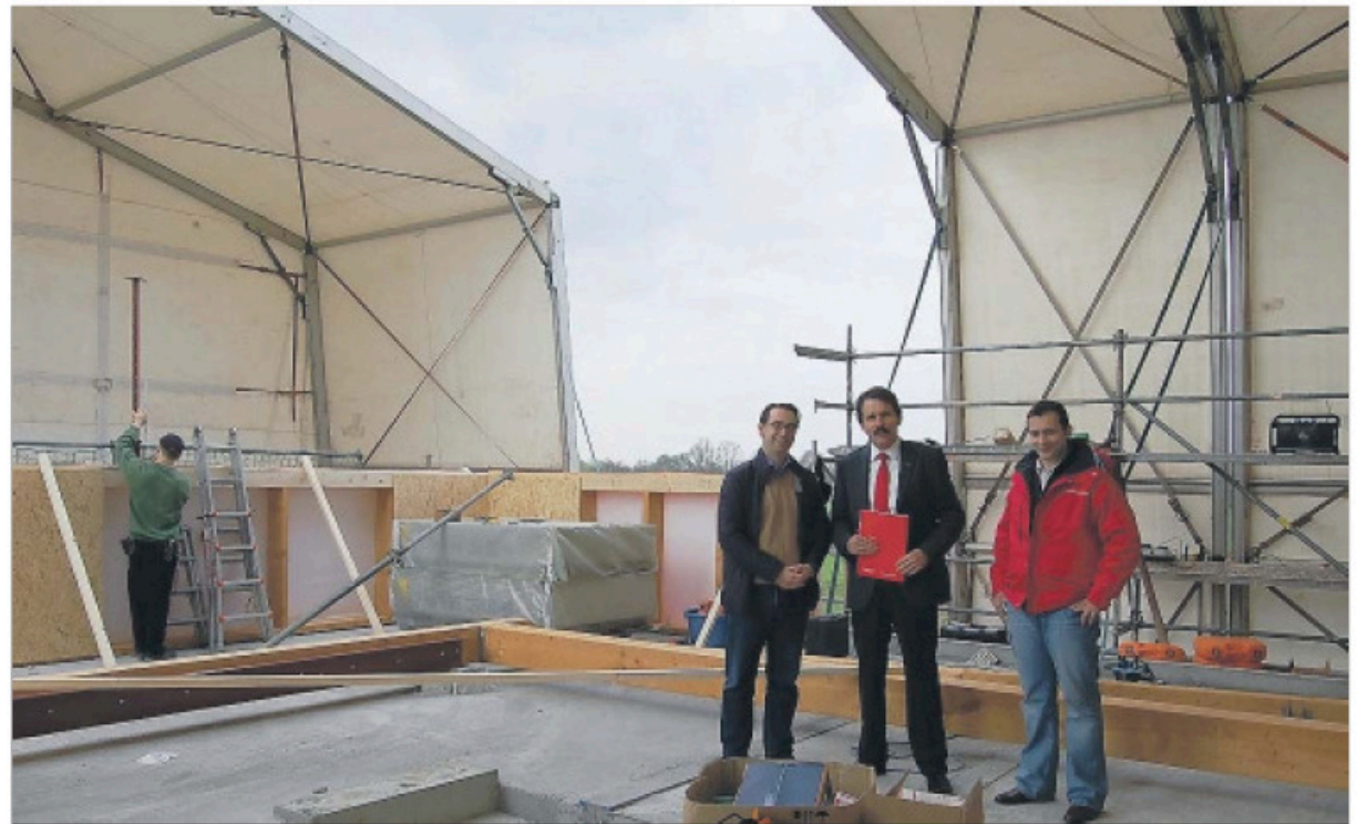
In Stollhofen wird unter dem schützenden Zelt ein Haus mit einer Wohnfläche von mehr als 200 Quadratmeter errichtet.
