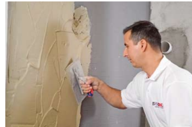
Auch bei der Untergrundvorbehandlung und später beim Oberbelag wird auf hohe Qualität geachtet.
