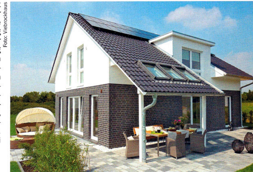
Bei den neuen Aktionshäusern wird ohne Aufpreis eine 4,68 kWp-Photovoltaikanlage auf der nach Süden geneigten Dachfläche installiert.
