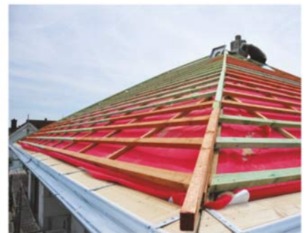
6. JUNI Richtfest: Der Dachstuhl steht. „Das leuchtende Rot der Folie ist schon aus weiter Ferne zu sehen.“
