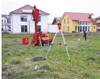
30. NOVEMBER Vorbereitungen: Entnahme der Bodenprobe auf dem Grundstück. Wie hoch steht das Grundwasser?
