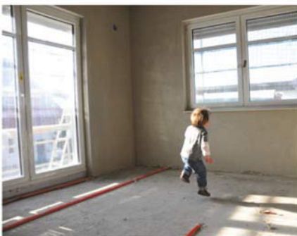
22. JUNI Alles dicht: Alle Räume des Hauses haben Fenster. „Nun kann der Nachwuchs sein Zimmer erobern!“
