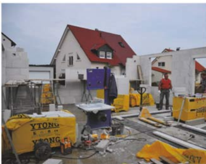
26. MAI Das Haus wächst: Innerhalb weniger Tage werden alle Wände des Erdgeschosses hochgezogen.
