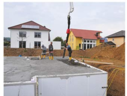
10. MAI Der Keller ist fast fertig: Elf Tage nach Baubeginn wird die Kellerdecke betoniert. „Geht alles schneller als gedacht.“
