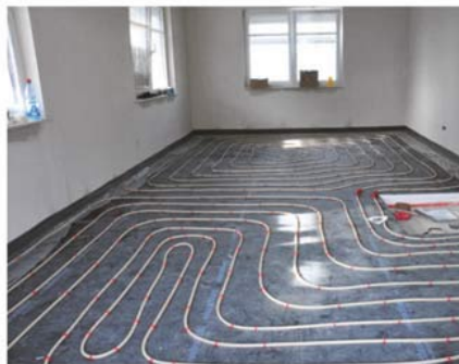
1. JULI Wärme von unten: Die Fußbodenheizung wird verlegt. „Fehlen nur noch Estrich, Fliesen und Parkett.“
