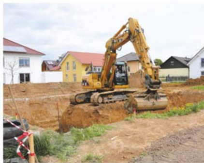
30. APRIL Jetzt geht's los: Der Bagger kommt. „Gestern war Spatenstich! Die Grube ist heute schon fast fertig.“
