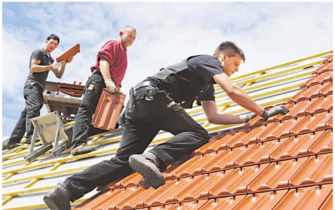
Wer sein Dach neu decken lassen möchte, muss sich vielerorts im Norden derzeit in Geduld üben. Viele Handwerker sind ausgelastet Foto: dpa
