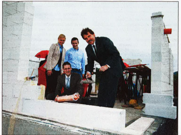
Yasmin Schütte, Bürgermeister Manuel Just, Markus Deden und Andreas Viebrock (v. li.) versenkten bei der Grundsteinlegung eine Kapsel – unter anderem mit einer RNZ. Foto: Kreuzer
