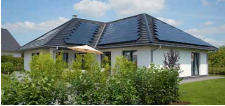
■ Das solare Kraftwerk auf dem Dach wurde harmonisch in die Architektur des Hauses eingebunden.
