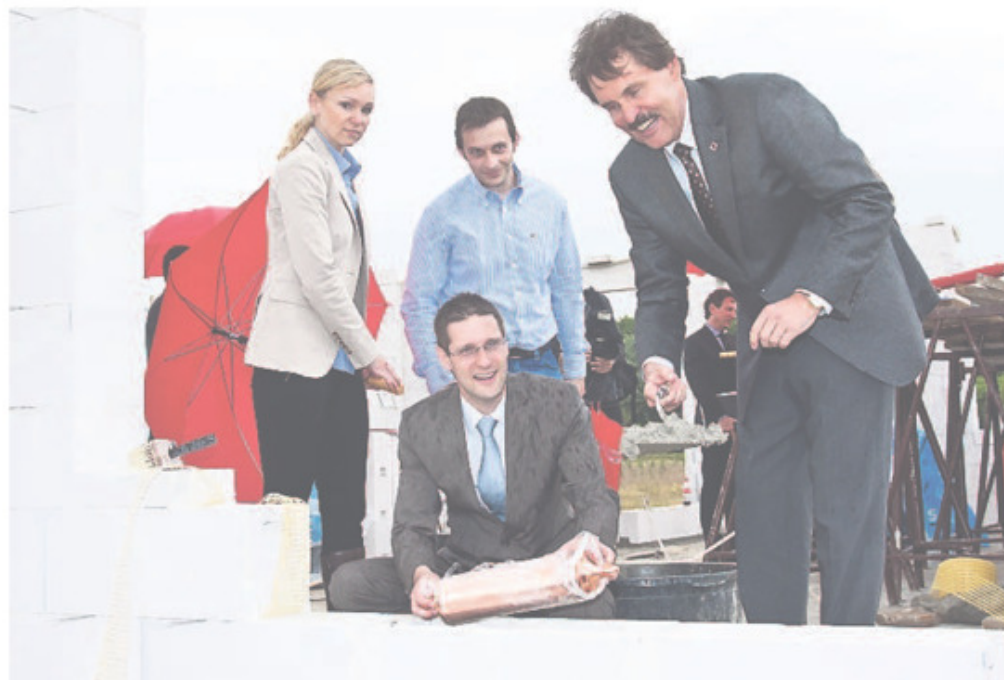
Grundsteinlegung im Sterzwinkel für ein „energieautarkes“ Haus: Yasmin Schütte, Markus Deden und Andreas Viebrock (von links) von der Firma Viebrockhaus und knieend Bürgermeister Manuel Just.
