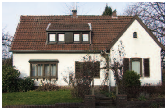
Das Einfamilienhaus aus dem Jahr 1949 hätte aufwendig saniert werden müssen. Die Bauherren entschieden sich für einen Abriss und Neubau.
