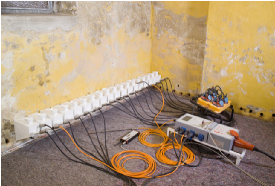
Nasse Wand ade: Mit dem Injektionsverfahren bleibt die Nässe draußen. (Foto: Isotec)
