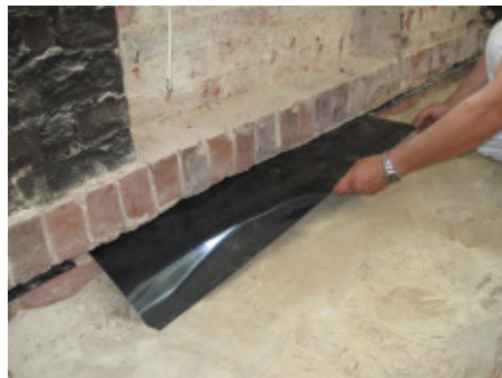
Verhindert das Eindringen von Wasser: das Einziehen einer durchgehenden Sperrschicht. (Foto: Isotec)
